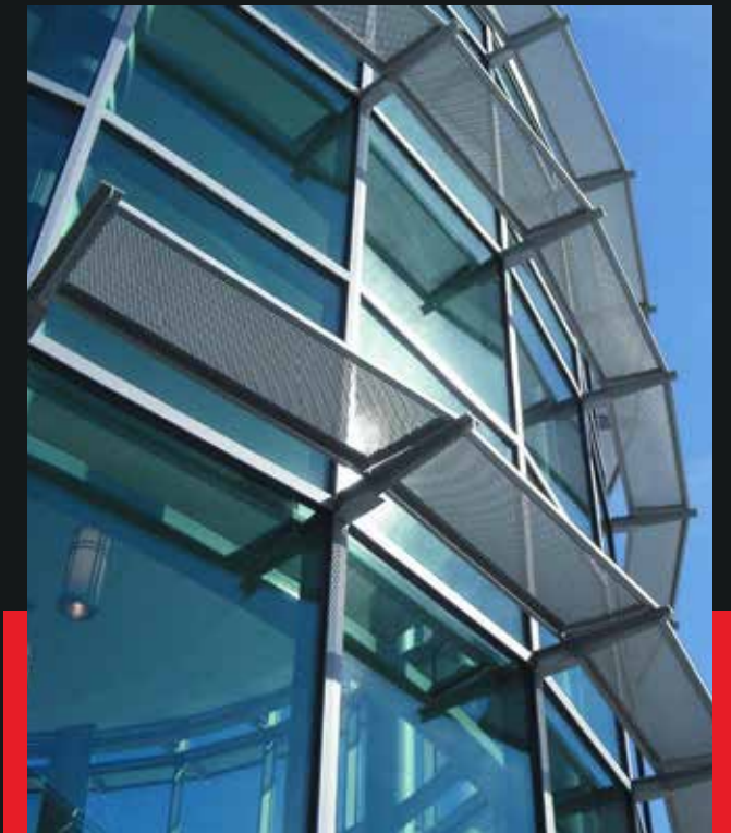
Glass Fins / Sunshade Panels
