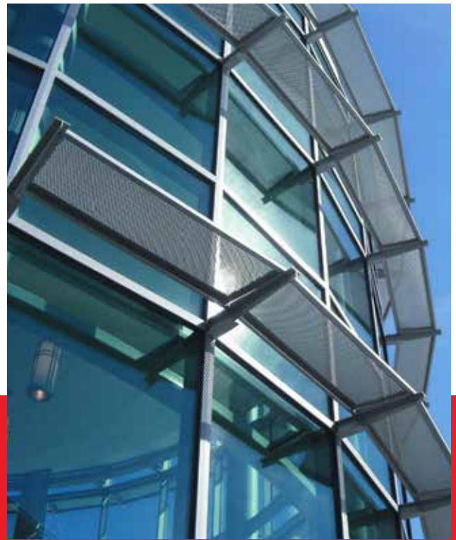
Glass Fins / Sunshade Panels
