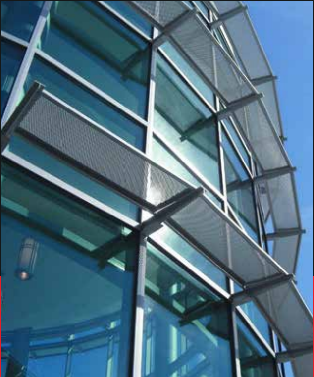
Glass Fins / Sunshade Panels
